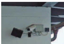
Kamera und IR-Strahler sind in völlig verschiedene Richtung ausgerichtet.
