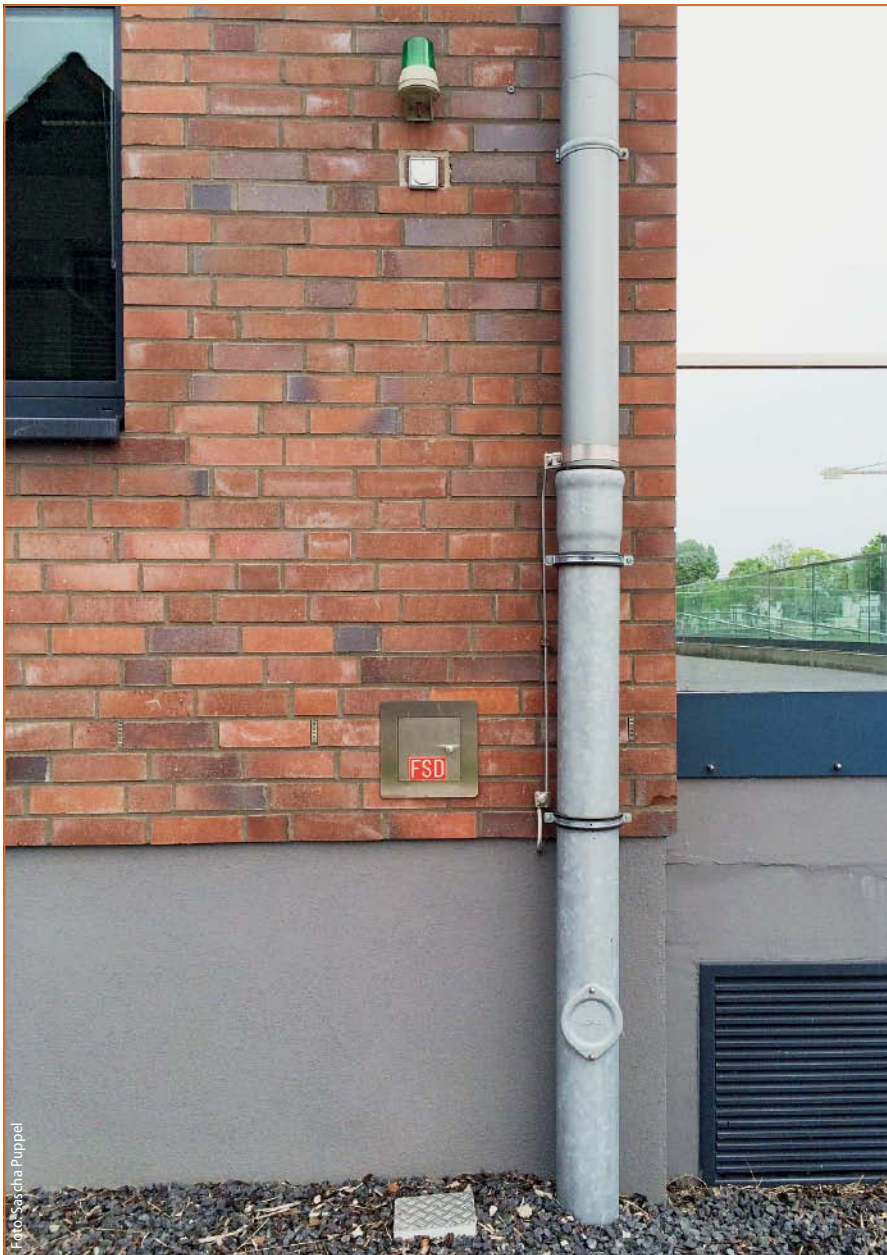
Abb. 3: Unzulässiger Trennungsabstand zwischen Geräten und Blitzableitung
